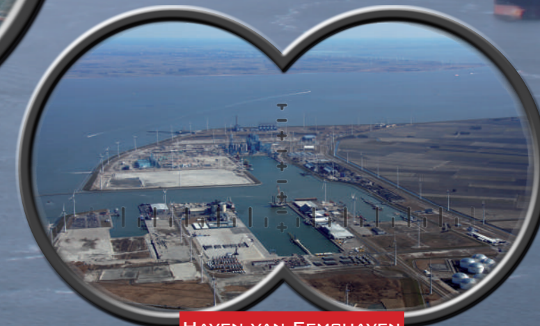
HAVEN VAN EEMSHAVEN
